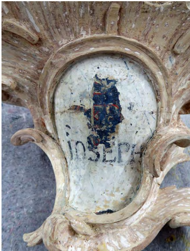
Abb. 1.09: Hochaltar, Linker Skulpturensockel. Zustand nach Abnahme der jüngsten Grundier- und Fassungsschichten mit älteren Beschriftungsresten im Spiegelfeld aus zwei zeitverschiedenen Zustandsphasen.
