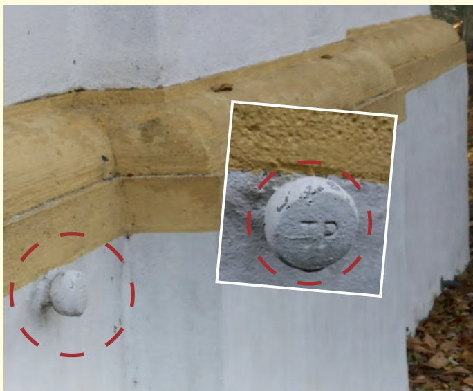
Bild 1: Dieses runde Metallteil, ein Turmbolzen, befindet sich seit 1956 unverrückbar 99 cm über Bodenhöhe am Sockel der rechten Außenfassade der Marienkapelle.
