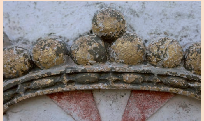
Die ersten Untersuchungen der alten Schichten ließen erkennen, wie ungleichmäßig der Goldauftrag bei der ersten Restaurierung vor ca. 30 Jahren angebracht war. Diese Unregelmäßigkeiten führten zu Ablösungen, die jetzt erneute Restaurierungsarbeiten erforderlich machten.
