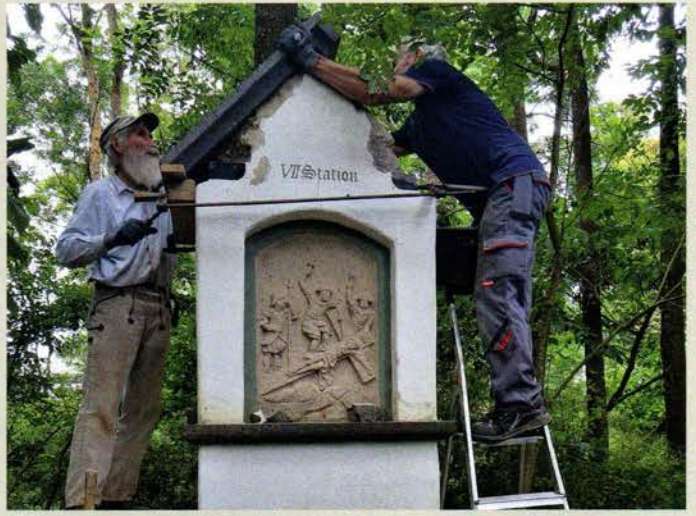
Steine sind schwer, besonders Basalt. Hier werden das vorgefertigte Giebelstück und die neuen Dachplatten eingepasst und verankert.
